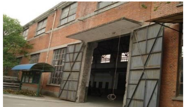
(d) Brick workshop with seismic design
