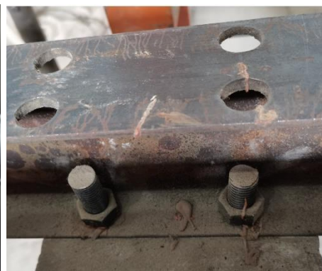
(d) Consolidation of girder and pier
